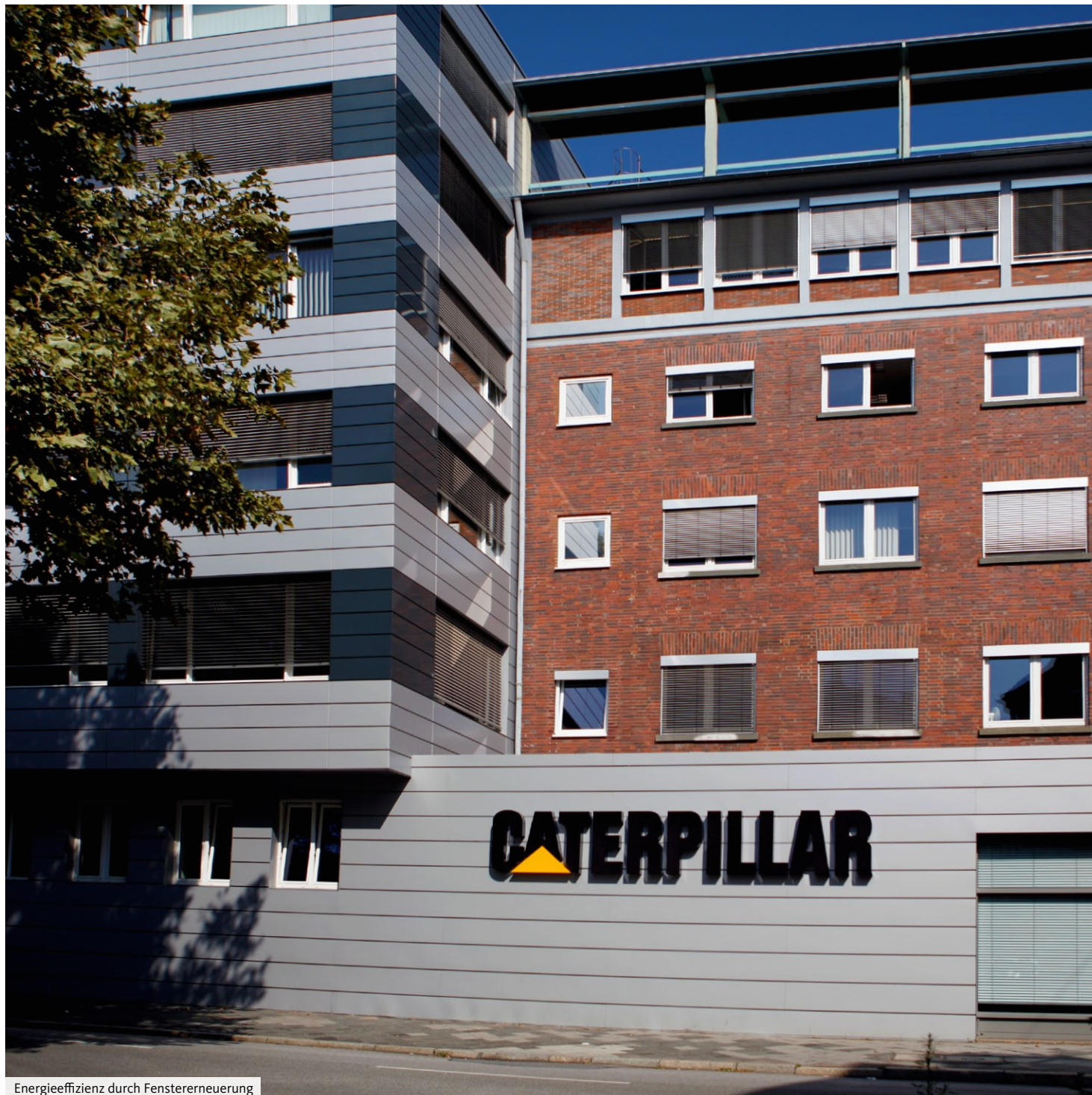
Energieeffizienz durch Fenstererneuerung
